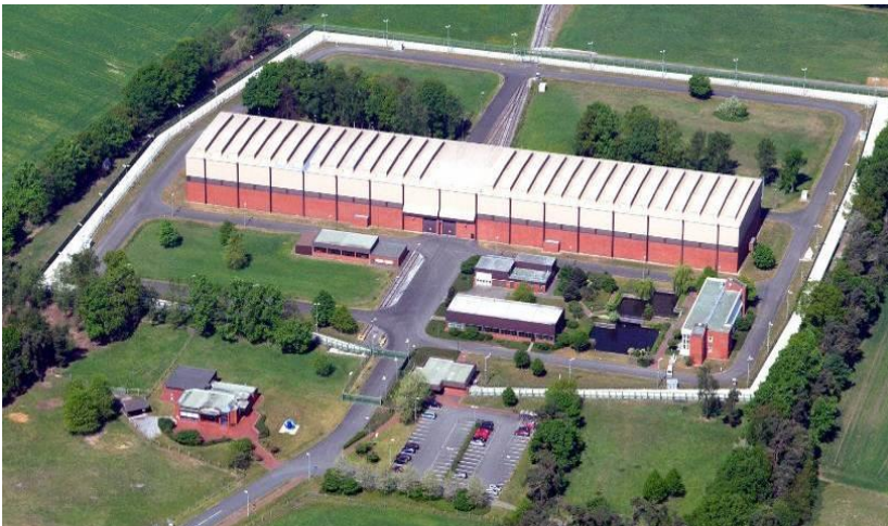
Abbildung G-2: Transportbehälterlager Ahaus (Bildrechte: GNS)
